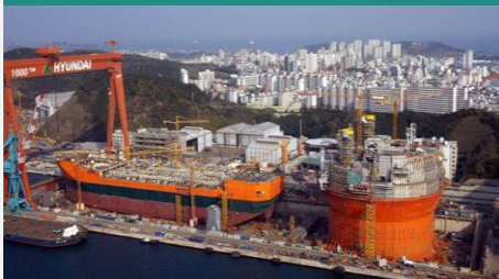
해양 전용 도크 및 Yard
