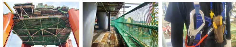
추락 방지망 설치
