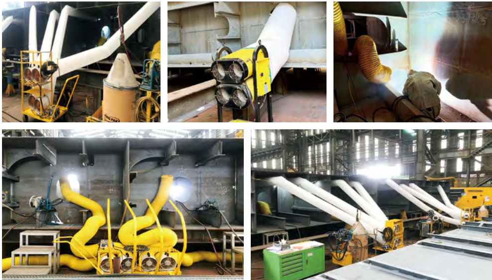
흡배기를 이용한 환기 실시 및 소음저감 자동화 설비 사용
