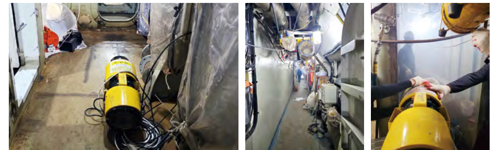
수상함 내부 환기 개선을 위한 제트팬 설치
